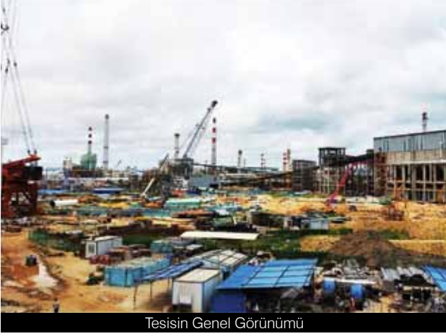
Tesisin Genel Görünümü
